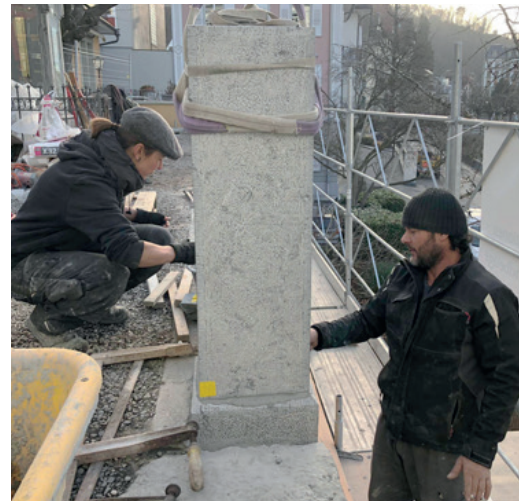
Montage der neuen Postamente
