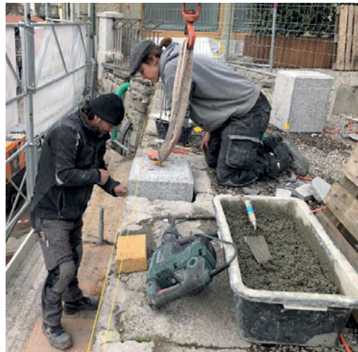
Montage der Aufstellplatten
