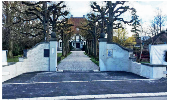
Endprodukt vor Deckputz
