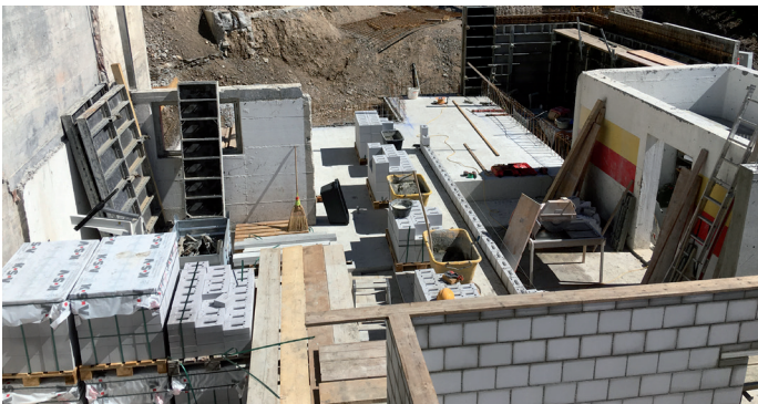
Eine sehr vielfältige und anspruchsvolle Baustelle
