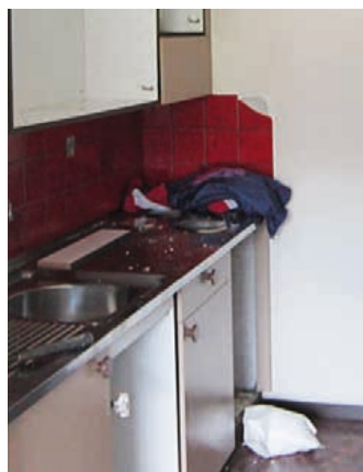
Abbrucharbeiten in der Küche
